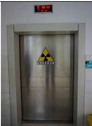
介入治疗室东侧病员出入防护门
